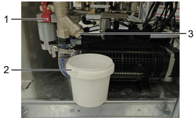
NOTA: Un recipiente colocado correctamente impedirá que el producto presente en el compartimiento de filtración se caiga ensuciando las superficies de abajo.
